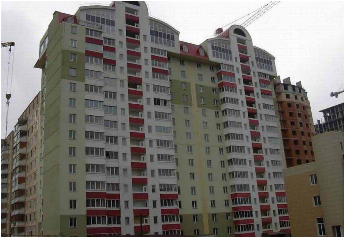
Рис. 1. Фасад 17-ти поверхового безкаркасно-монолітного будинку
