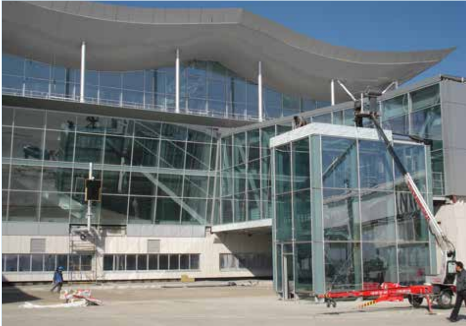
Монтаж металлоконструкцій в міжнародному аеропорту «Бориспіль»
